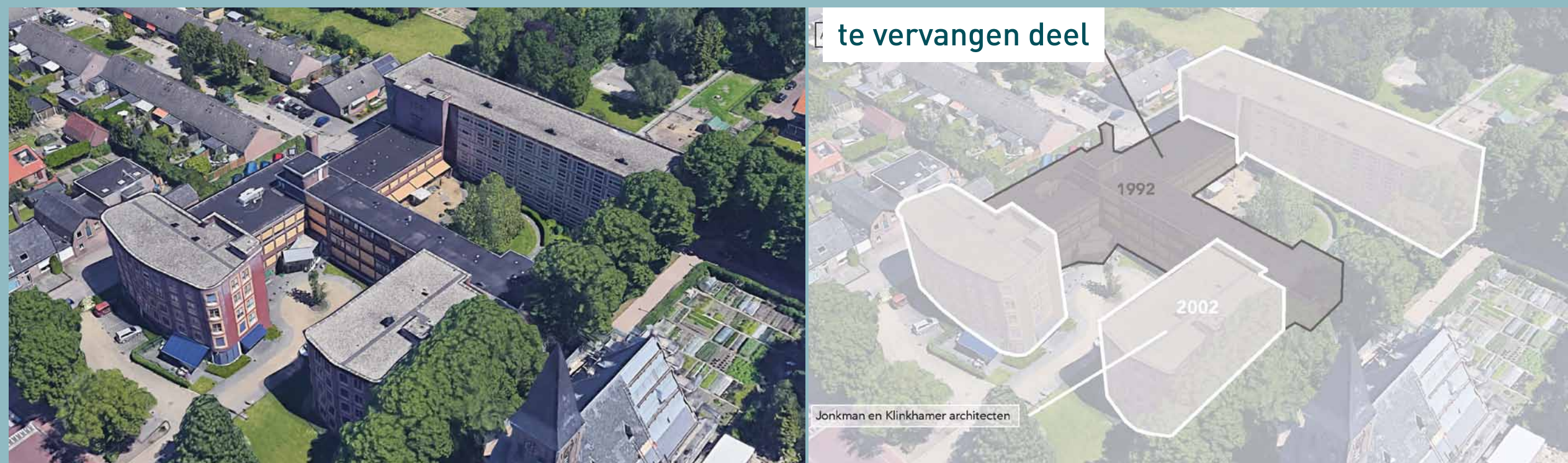
luchtfoto huidige situatie
